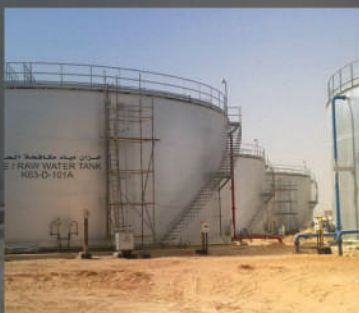
حزان مياه مكافحة الحريق FIRE / RAW WATER TANK K63-D-101A
